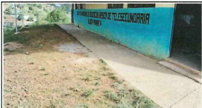
Foto 3: REPARACIÓN DE PARED Y PISO
