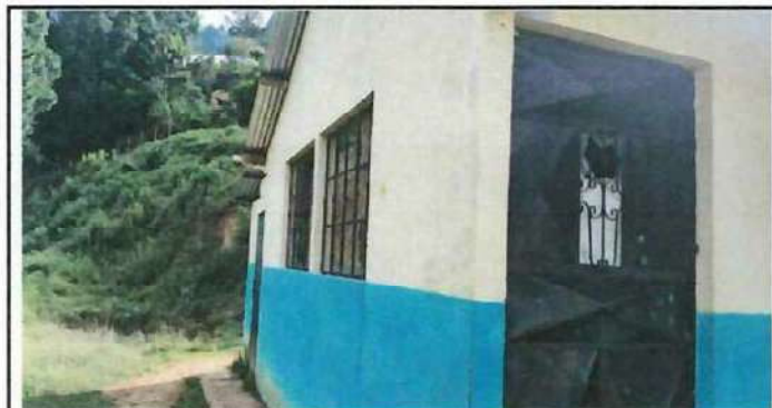
Foto 4: SUSTITUCIÓN DE PUERTAS, VENTANALES Y CAMBIO DE CUBIERTA DE PINTURA EN LAS PAREDES
