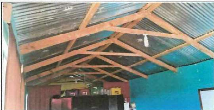
Foto1: CAMBIO DE ESTRUCTURA DE TECHO DE MADERA A METAL
