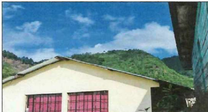
Foto 2: CAMBIO DE LÁMINAS A LÁMINAS TROQUELADAS
